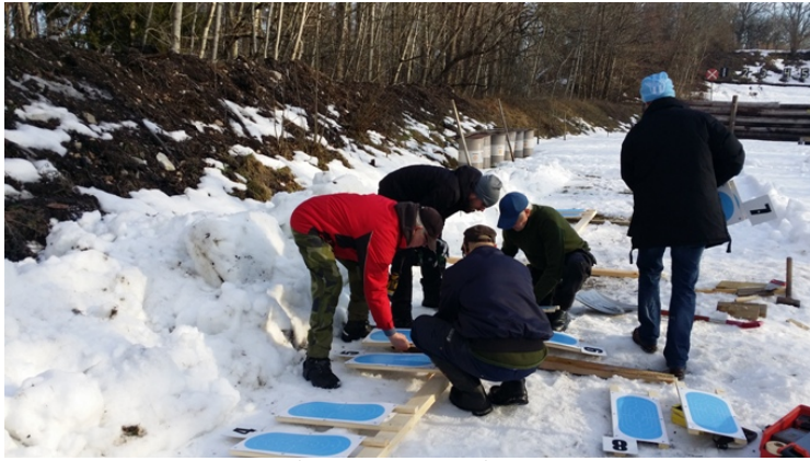
Målmaterial monteras på plats
