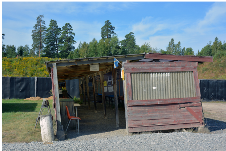
Den gamla, sneda hallen med läckage i taket har tjänat ut och är borta sedan juni 2016, men pistolskyttarna behöver nu en bättre, större och modernare skjuthall så fort som möjligt!
